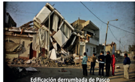
Edificación derrumbada de Pasco
