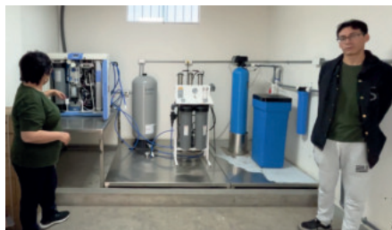
F3 Planta de Tratamiento de Agua que envía el agua al Electrolizador PEM Nel con una conductividad menor 1 microsiemens ( \mu\text{S}/\text{cm} )
