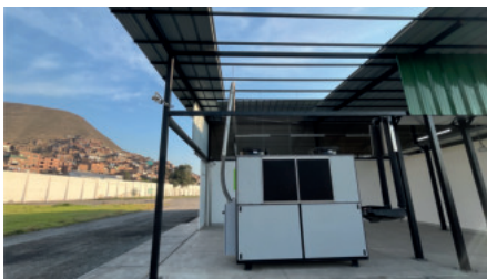
F2 Sistema de Agua de Enfriamiento Chiller
