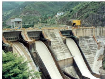
Central Hidroeléctrica de Machupicchu
