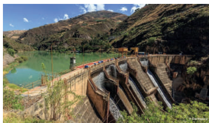
La Central Hidroeléctrica del Mantaro
